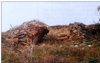
8. Τμήμα του τείχους που στηρίζεται με αντηρίδες.
