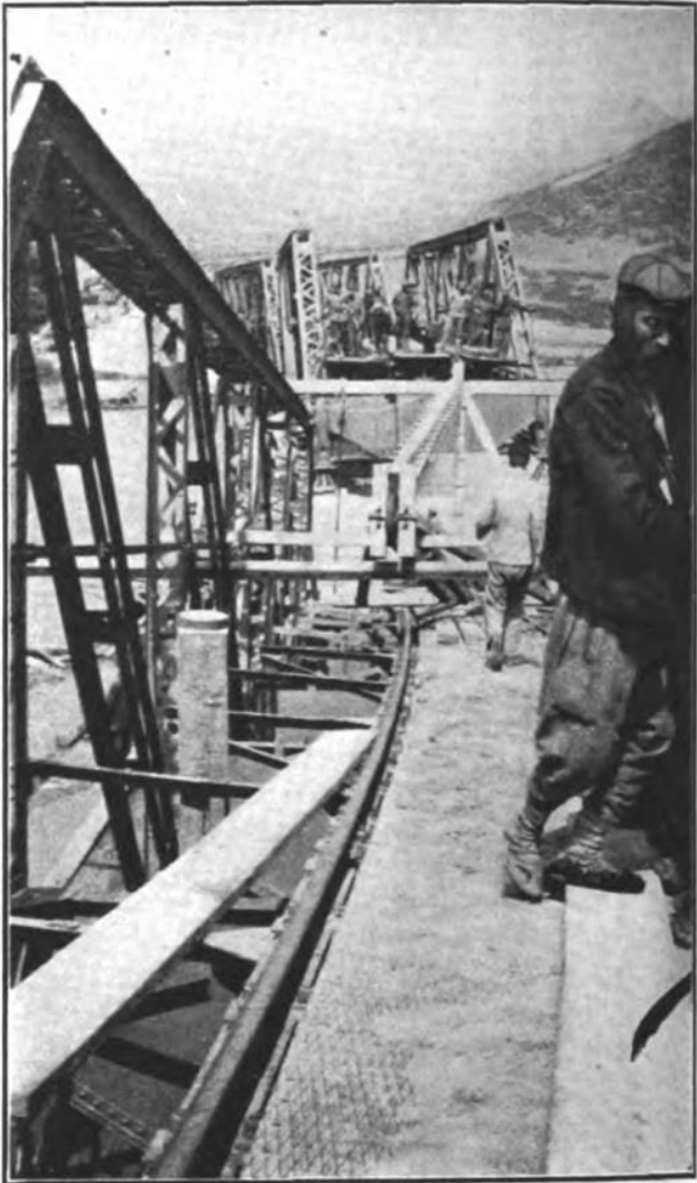
Η ΚΑΤΑΣΤΡΑΦΕΙΣΑ ΣΙΔΗΡΟΔΡΟΜΙΚΗ ΓΕΦΥΡΑ ΔΕΜΙΡ-ΧΙΣΣΑΡ
