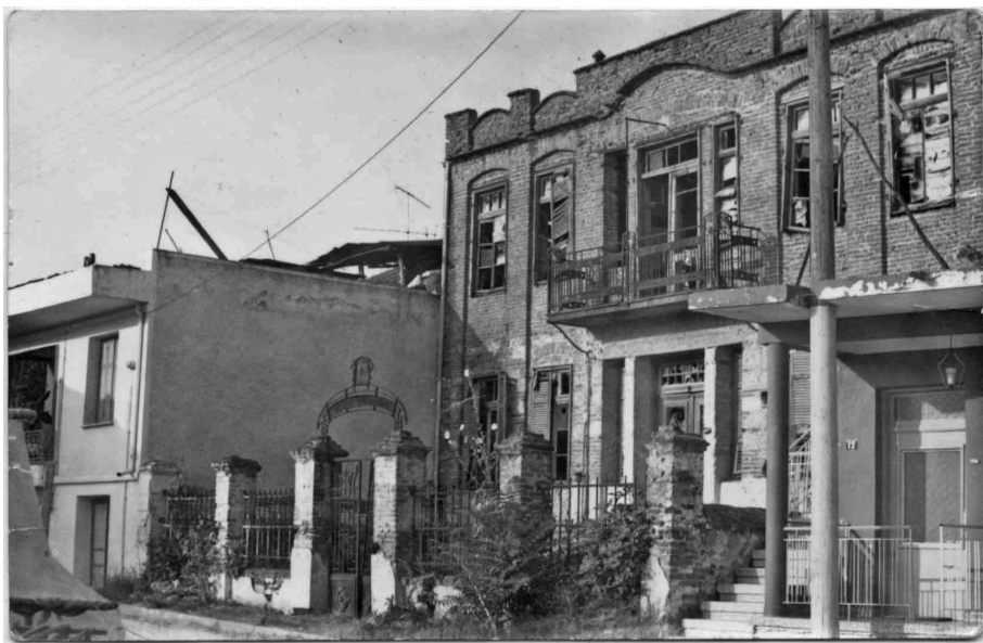
Το σπίτι του Γεώργιου Ρούντου στη Νιγρίτα, λίγο πριν την κατεδάφισή του.
