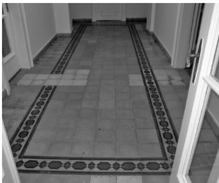
Εικ. 15: Δάπεδο διαδρόμου από τσιμεντοπλακίδια Πηγή: Αρχείο Στ. Παπότη
