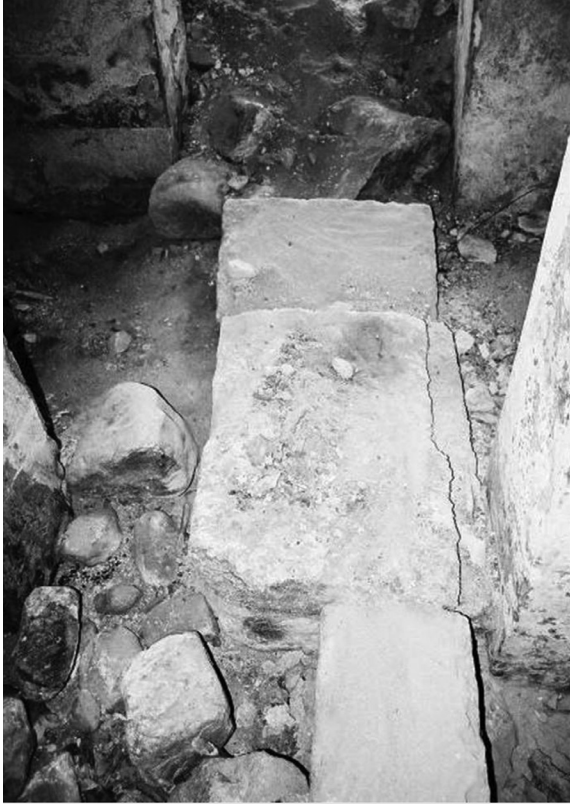
Εικ. 7. Η εικόνα της καταστροφής στο εσωτερικό του προθαλάμου. Άποψη από ανατολικά.
