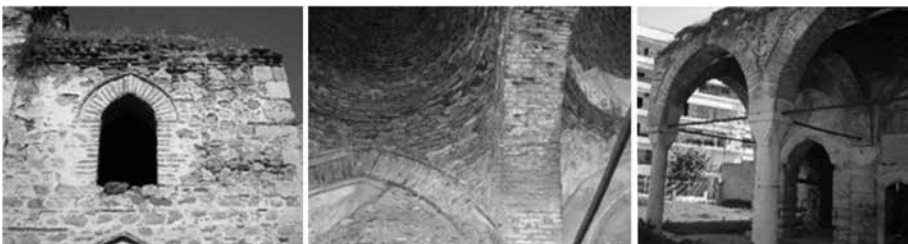
Εικ. 9: α. τμήμα εξωτερικής τοιχοποιίας, β. εσωτερικά οι θολίσκοι του προστώου, γ. άποψη του προστώου.
