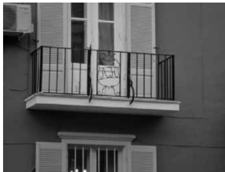
Εικ. 5: Αναγραφή στα κιγκλιδώματα των εξωστών του ορόφου τα αρχικά «ΑΗ», από τα αρχικά της ιδιοκτήτριας εταιρείας «Αυστροελληνική Εταιρεία Καπνών Α.Ε.». Πηγή: Αρχείο Στ. Παπότη.
