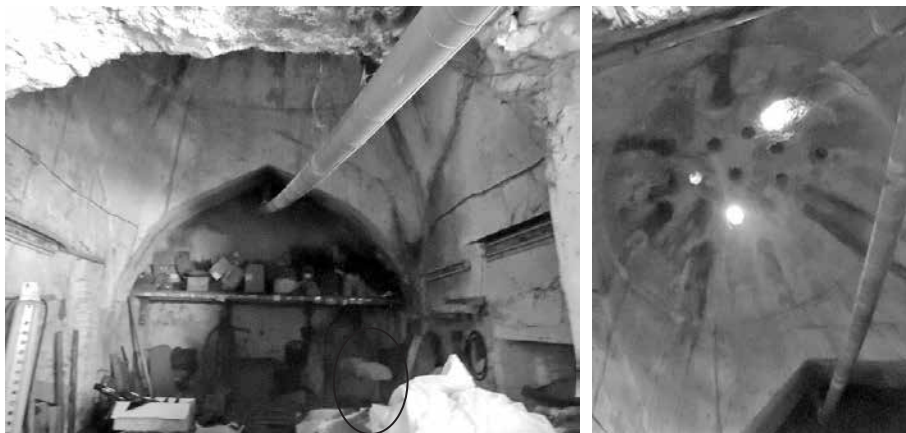
Εικ. 54, 55. Η αριστερή φωτογραφία αποτυπώνει το χώρο του χλιαρού τμήματος στο γυναικείο τμήμα (ανατολικό) του χαμάμ. Το οξυκόρυφο τοξωτό άνοιγμα που διακρίνεται ένωνε τον κεντρικό χώρο του κεντρικού χλιαρού τμήματος με το θόλο με τον μακρόστενο δεύτερο χώρο του χλιαρού τμήματος (διακρίνεται ο τοίχος στο βάθος με το ξύλινο ράφι) που έφερε σκαφοειδή στέγαση. Με το σχήμα της έλλειψη σημειώνεται το μικρό οξυκόρυφο χαμηλό άνοιγμα που οδηγούσε από τον μακρόστενο διάδρομο στο χλιαρό τμήμα του γυναικείου τμήματος του χαμάμ. Στη δεξιά φωτογραφία αποτυπώνεται ο θόλος του κεντρικού αυτού χλιαρού τμήματος, όπου διακρίνεται και η διάταξη σε ομόκεντρους κύκλους των φωτιστικών οπών που αποτυπώνεται και στην κάτοψη του M. Kiel (φωτ.τ.σ., 2017).
