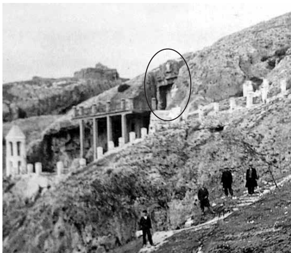
Εικ. 60. Φωτογραφία εποχής από την περίοδο της ανέγερσης του ναού του Αγ. Δημητρίου, Αγ. Κηρύκου και Ιουλίττας και Αγίας Ζώνης (1939), όπου διακρίνονται οι κολώνες από οπλισμένο σκυρόδεμα για τη δημιουργία της εξέδρας, όπου στηρίχθηκε ο ναός. Στο βάθος της εξέδρας, προς τα δεξιά, διακρίνεται καθαρά ο λαξευμένος στον βράχο μακεδονικός τάφος (σε κύκλο), πριν αυτός κα-
