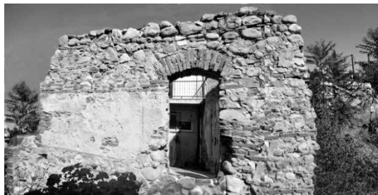
Εικ. 24, 25. Τα μοναδικά υπολείμματα από το Τσαρσί Τζαμί στη ΝΑ γωνία του τζαμιού με το γωνιακό πίσω παράθυρο του μνημείου να διασώζεται σε αρκετά καλή κατάσταση. Το παράθυρο φέρει την κλασική καμπύλη στέψη και η όλη κατασκευή αποτελείται αποκλειστικά από αργολιθοδομή με εγκάρσιες ζώνες οπτόπλινθων και ξυλοδεσιών (φωτ.τ.σ., 2017).
