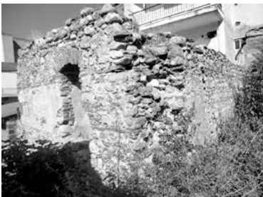
Εικ. 24, 25. Τα μοναδικά υπολείμματα από το Τσαρσί Τζαμί στη ΝΑ γωνία του τζαμιού με το γωνιακό πίσω παράθυρο του μνημείου να διασώζεται σε αρκετά καλή κατάσταση. Το παράθυρο φέρει την κλασική καμπύλη στέψη και η όλη κατασκευή αποτελείται αποκλειστικά από αργολιθοδομή με εγκάρσιες ζώνες οπτόπλινθων και ξυλοδεσιών (φωτ.τ.σ., 2017).
